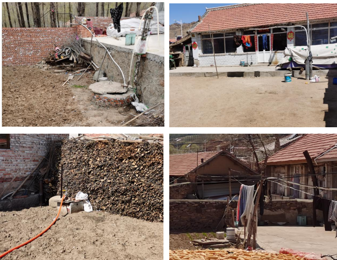
图 3-2 农村供水现状图
